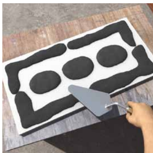
Método de Cordón de Mortero
