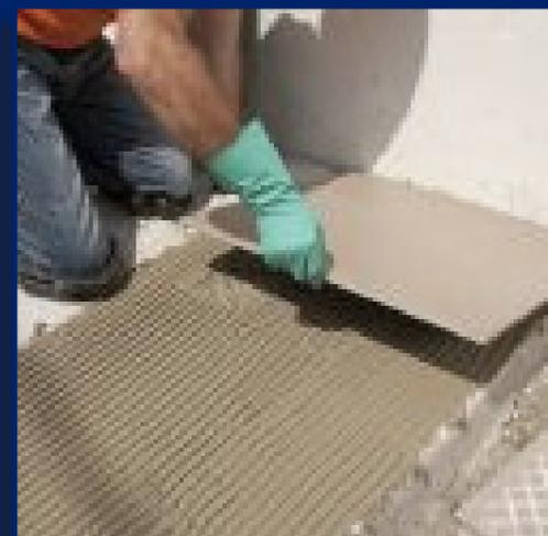
baldosas de formato reducido, doble encolado, junta de colocación muy abierta) o con capa intermedia de desolidarización entre el soporte base y el material de agarre. Debe cumplir:
