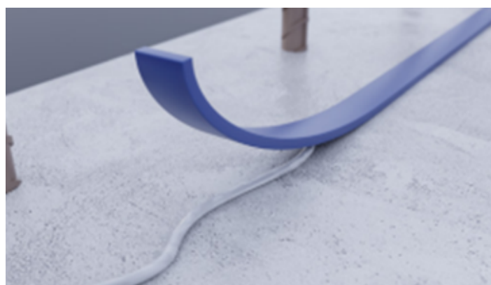
POSE DU PROFILÉ AVEC DU PUMALASTIC MS
