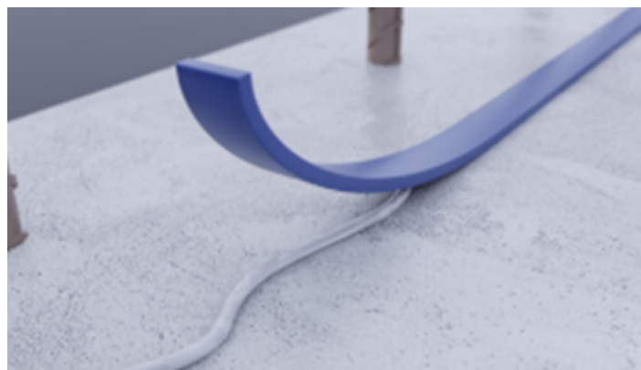
POSE DU PROFILÉ AVEC DU PUMALASTIC MS
