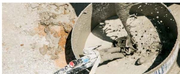
Es habitual, en los rellenos de perforaciones geotérmicas, la utilización de grava fina. Si bien esta solución puede ser válida en terrenos con humedad garantizada, **en terrenos secos o con niveles variantes de humedad la falta de compactación del relleno puede producir como se ha indicado huecos que actúan como aislantes, reduciendo importante y peligrosamente la conductividad térmica del espacio anular, disminuyendo consecuentemente la capacidad de absorción y/o disipación de la sonda.**
