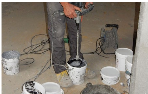
Preparación del Adhesivo Carbotec Lámina
