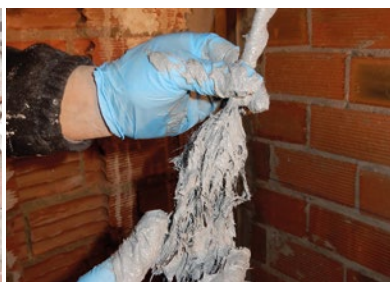
Impregnar el Cordón Carbotec con el Adhesivo Carbotec Lámina
