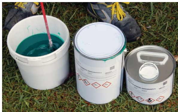
Preparación del Adhesivo Carbotec Impregnante
