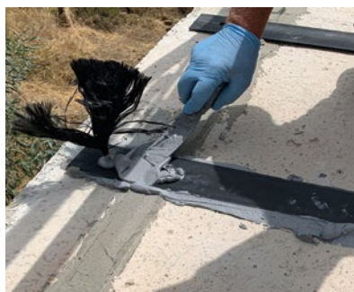
Colocar el Cordón Carbotec en el extremo del laminado, previa realización y limpieza de la perforación.*
