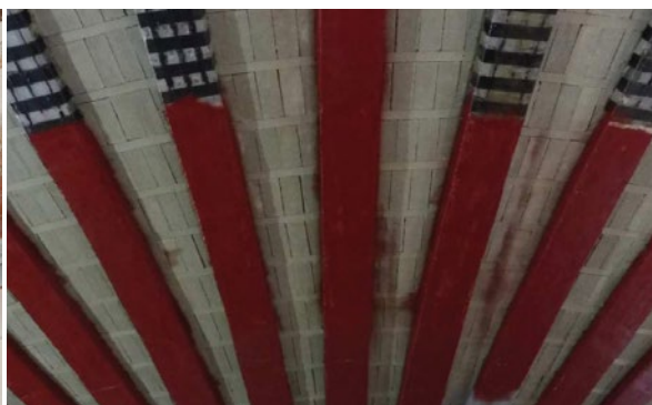
Una vez seco el espolvoreo del paso anterior, proceder a la aplicación del revestimiento protector.
