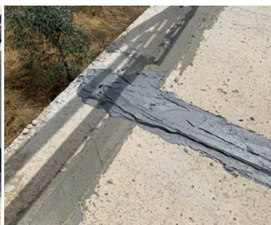
Extender y pegar las fibras de la zona flexible del Cordón Carbotec.*
