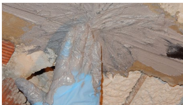
Extender y pegar las fibras de la zona flexible del Cordón Carbotec
