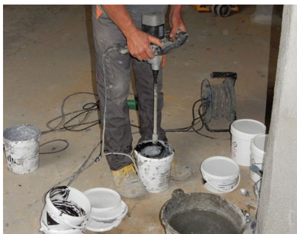
Preparación del Adhesivo Carbotec Lámina
