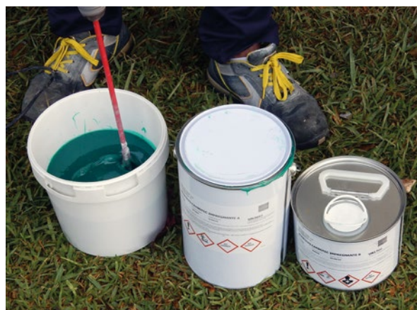
Preparación del Adhesivo Carbotech Impregnante
