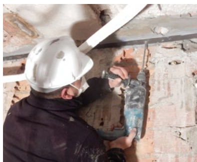
Realizar taladros en la zona media del laminado y limpiar el polvo generado en las perforaciones.
