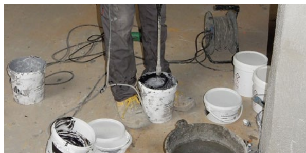
Preparación del Adhesivo Carbotech Lámina
