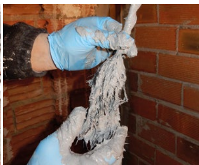
Impregnar el Conector Carbotec con el Adhesivo Carbotec Lámina
