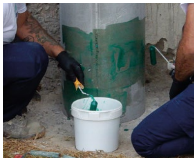
Aplicar el Adhesivo Carbotec Impregnante sobre el soporte con un rodillo de pelo corto.
