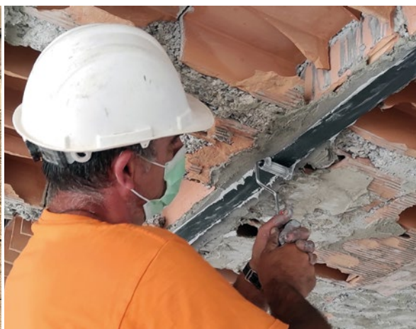
Aplicar presión sobre el laminado adherido al soporte con un rodillo adecuado. Limpiar el exceso de adhesivo
