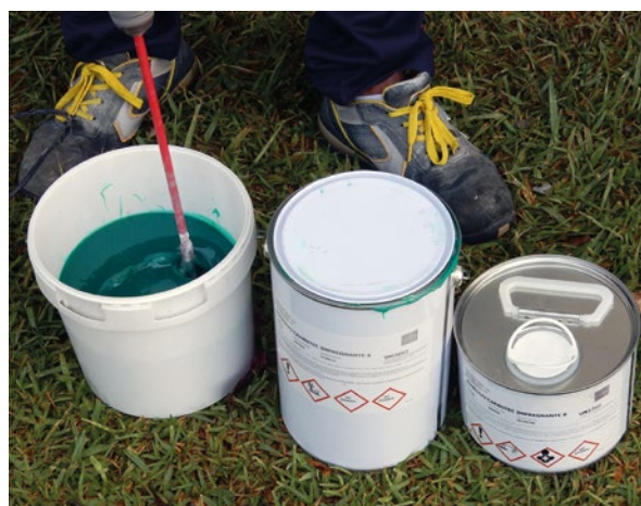
Preparación del Adhesivo Carbotec Impregnante
