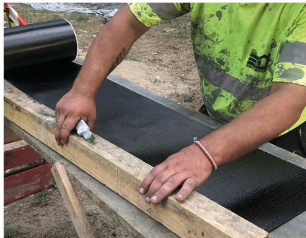
Corte del Tejido Carbotec con Cutter
