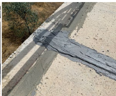
Extender y pegar las fibras del Conector Carbotec.*
