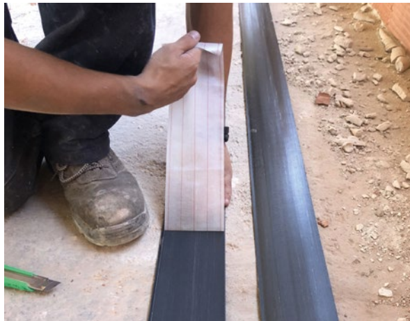
Retirada de la banda "peel-ply"
