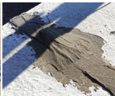
Espolvorear arena de sílice sobre el Adhesivo Carbotec Lámina aún fresco, como paso previo a la puesta en obra del revestimiento de protección.*
