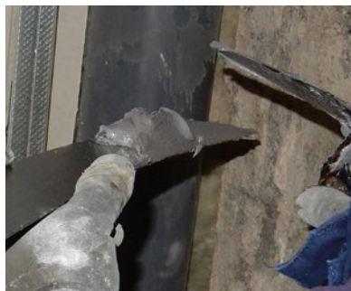
Aplicación del Adhesivo Carbotec con espátula
