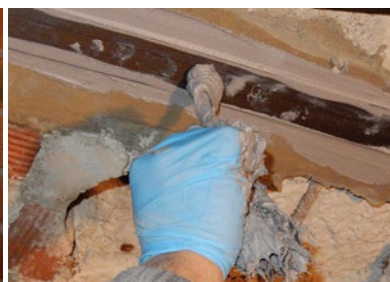
Introducir el Cordón Carbotec en la perforación realizada.
