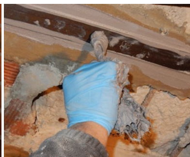
Introducir el Conector Carbotec en la perforación realizada.
