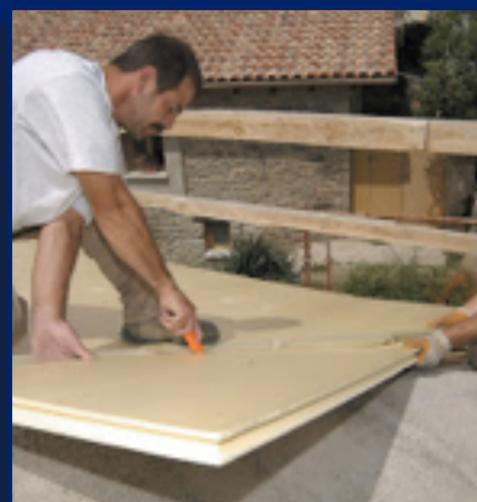
Además, el poliestireno extruido es de los pocos materiales aislantes que no se degradan en presencia del agua, por eso, el aislamiento de la cubierta durará toda la vida.
