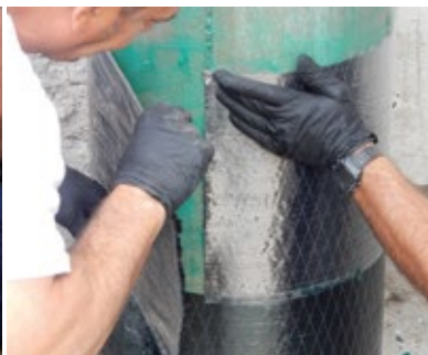
Colocar las bandas de tejido, previamente cortadas, prestando especial atención a la orientación de las fibras.
