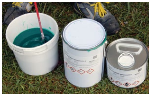
Preparación del Adhesivo Carbotec Impregnante
