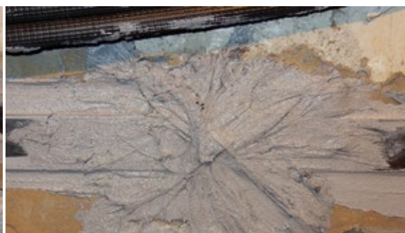
Imagen del Cordón Carbotec extendido
