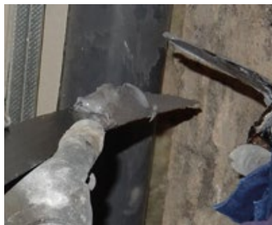
Aplicación del Adhesivo Carbotec con espátula
