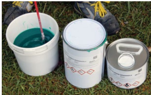
Preparación del Adhesivo Carbotec Impregnante
