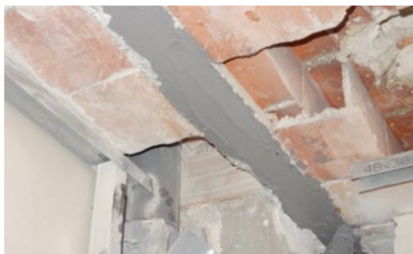
Si se desea aplicar un revestimiento protector, aplicar, en primer lugar, Adhesivo Carbotec Lámina sobre la cara inferior del laminado y espolvorear en fresco arena de sílice seca.
