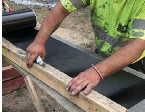
Corte del Tejido Carbotec con Cutter
