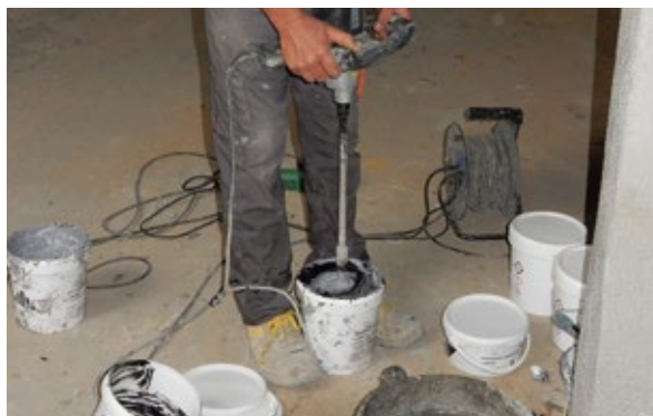
Preparación del Adhesivo Carbotec Lámina
