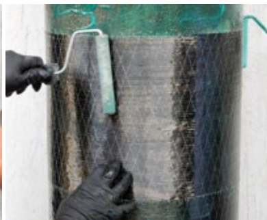
Aplicar presión con el rodillo adecuado sobre el tejido recién colocado para eliminar arrugas y posibles bolsas de aire ocluido.
