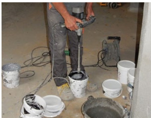
Preparación del Adhesivo Carbotec Lámina
