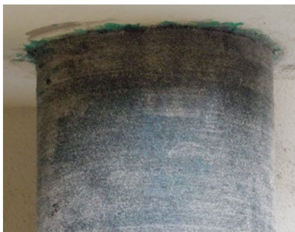
Espolvorear árido de sílice sobre la capa de Adhesivo Carbotec Impregnante para generar rugosidad.
