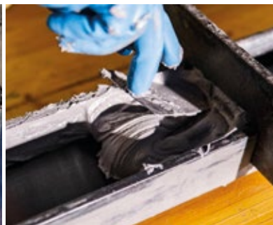
Aplicación del Adhesivo Carbotec con guillotina
