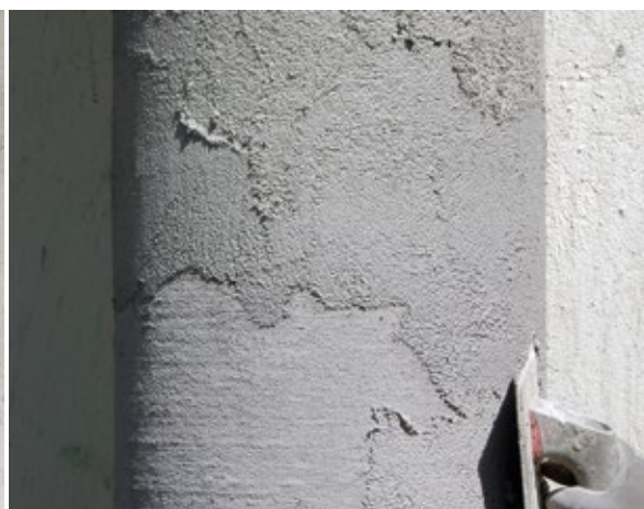
Aplicar la capa de protección y el revestimiento final para garantizar la durabilidad del refuerzo estructural.
