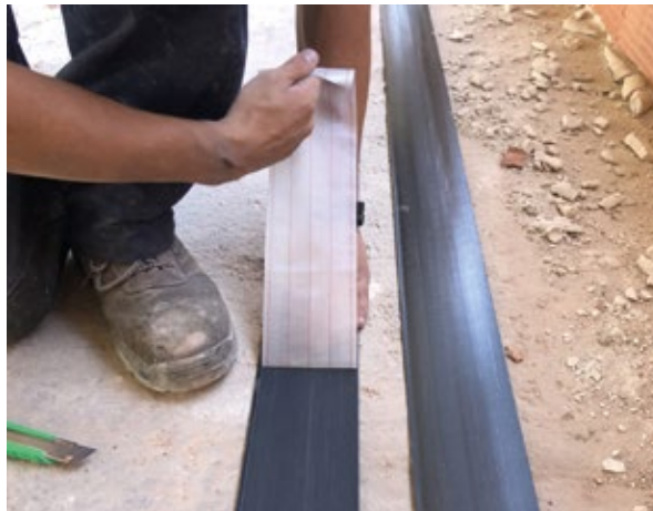
Retirada de la banda "peel-ply"
