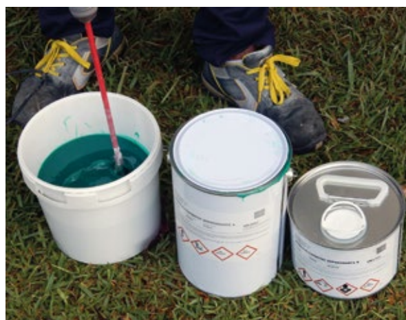
Preparación del Adhesivo Carbotec Impregnante
