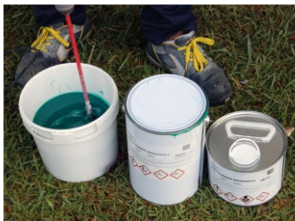
Preparación del Adhesivo Carbotech Impregnante
