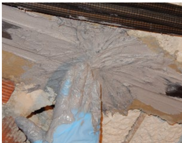
Extender y pegar las fibras del Conector Carbotec
