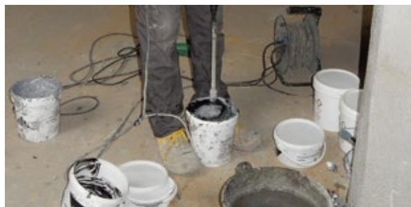
Preparación del Adhesivo Carbotec Lámina
