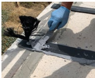
Colocar el Conector Carbotec en el extremo del laminado, previa realización y limpieza de la perforación.*
