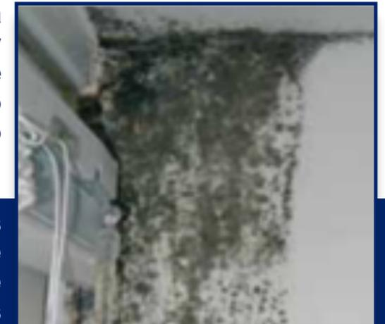
Este sistema para eliminar las humedades debe estar compuesto por un producto de limpieza, un fondo aislante y una pintura de acabado resistentes a la proliferación de algas y mohos.
