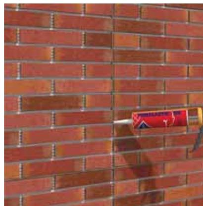
24 h minimum après la pose de la céramique avec l'adhésif Traditem® Ceramic, effectuer le remplissage des joints à l'aide du mortier Morcemcolor® Plus flexible.
