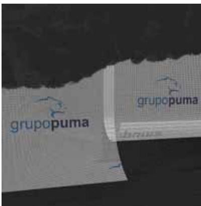
Une fois cette dernière couche durcie (il n'est pas recommandé de la laisser sécher plus de 24-48 heures, pour que le matériau ne durcisse pas trop et éviter l'apparition de fissures en posant les fixations), fixer les deux treillis à l'aide de la cheville d'ancrage Traditerm® Taco de Anclaje Plus NTK.
