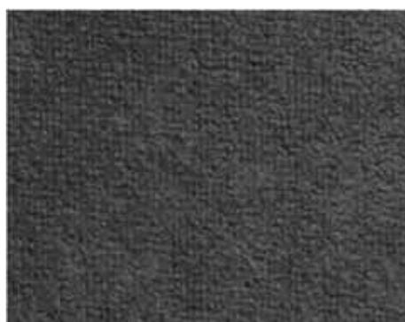
Quand cette couche atteint une certaine résistance superficielle, appliquer une nouvelle couche de mortier Traditerm®, à peigner avec une taloche dentée (n°6). Les sillons du mortier Traditerm® obtenus doivent sécher pendant 24 h minimum.
