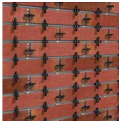
Tous les 4 m à l'horizontale et 3 m à la verticale, réaliser des joints de séparation scellés avec le mastic élastique Pumalastic® MS.
