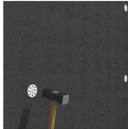
La première fixation se pose à n'importe quelle extrémité de la façade, à 15 cm des bords du système. Les fixations suivantes se posent à 1 m de distance par rapport à la fixation antérieure. Voir le schéma de distribution des fixations.
