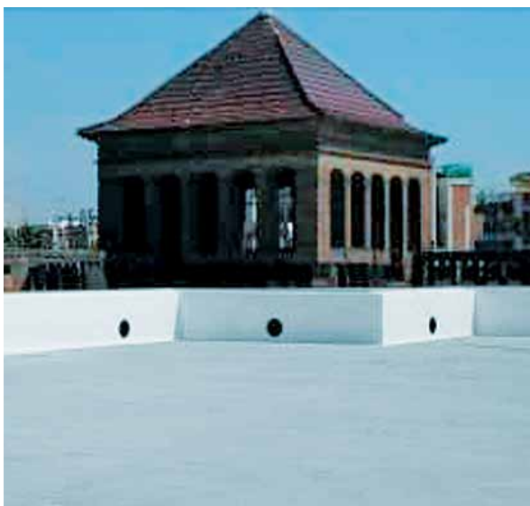
Toiture plane imperméabilisée avec MORCEM COVER
