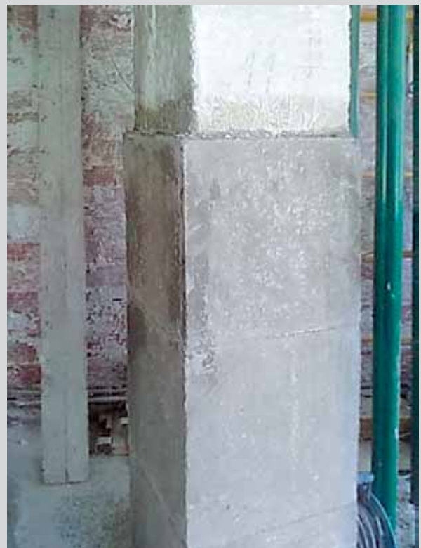
Pilier reconstruit et renforcé avec MORCEMREST MH avec application par déversement à Tavernes de Valldigna (Valence)
