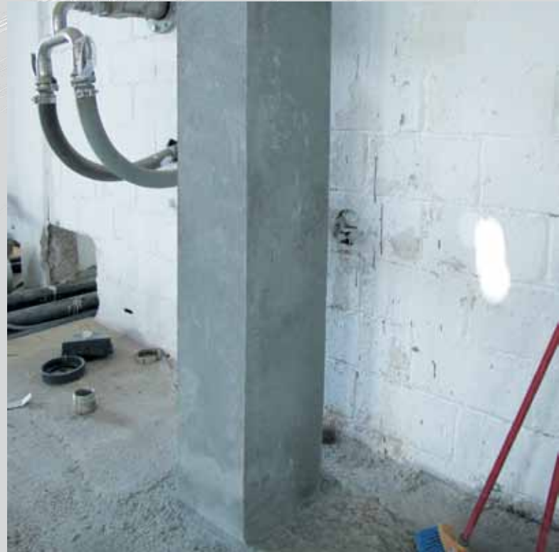
Finition de l'application manuelle de MORCEMREST EF 50 à Alameda (Malaga)
