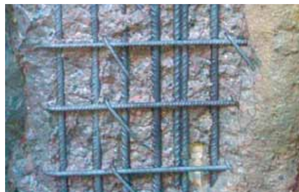
Type de désoxydation Sa2
