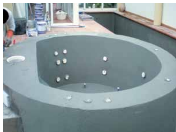
Imperméabilisation de jacuzzi avec MORCEMDRY F
