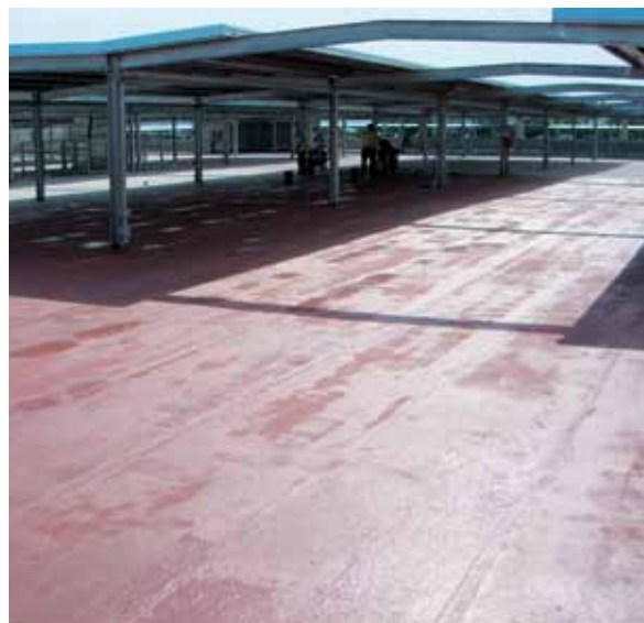
Imperméabilisation de toiture-parking avec MORCEM COVER
