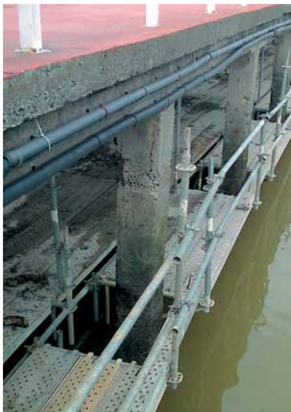
Inspection et diagnostic: pilier endommagé
