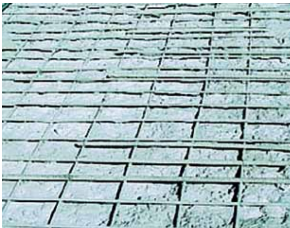
Piquage par hydrodémolition (piquage manuel avec burin).
