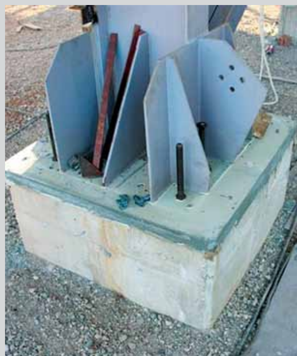
Nivellement avec MORCEM GROUT 500 dans une usine de biodiesel Andujar (Jaén)
