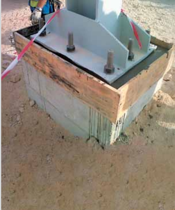
Nivellement avec MORCEM GROUT 500 Alcázar de San Juan (Ciudad Real)
