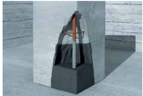
Réparation par mortier thixotropique
