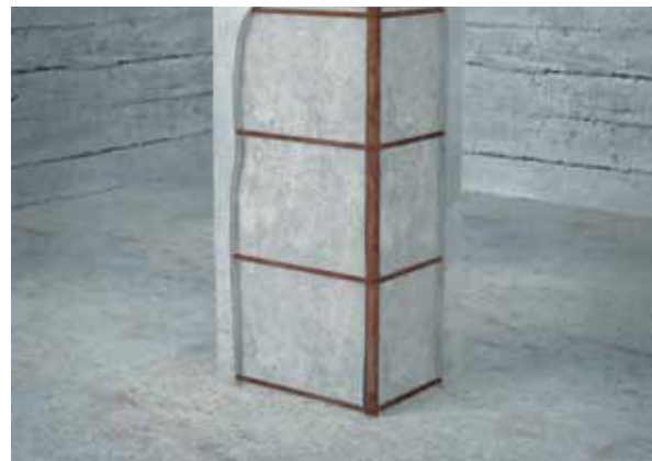
2- Mise à découvert de l'armature
