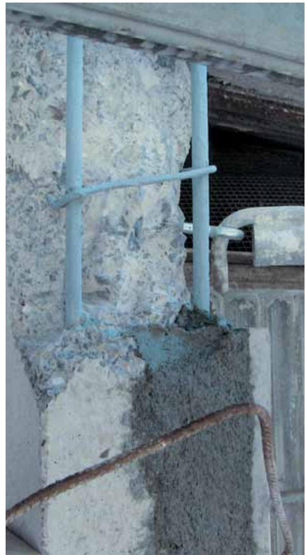
Armature découverte
