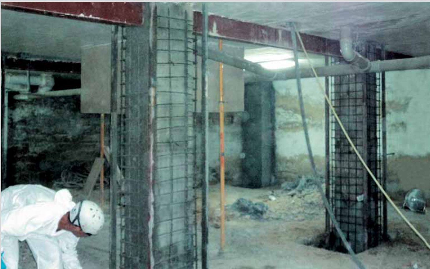
Application de MORCEMREST RF 15 par projection à Elche (Alicante)
