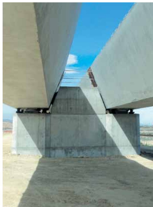
Nivellement d'appuis sur un tronçon ferroviaire de l'AVE à Crevillent (Alicante)
