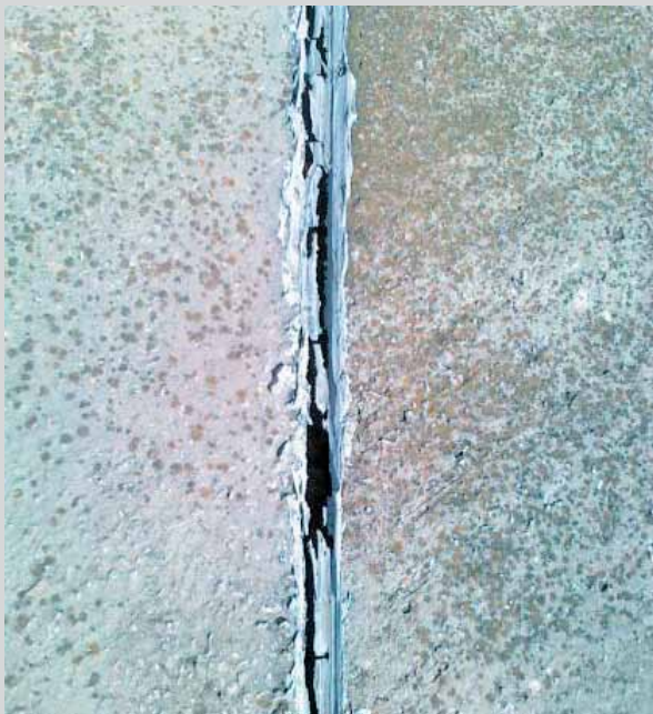
Détail d'un joint de la toiture du réservoir avec scellement détérioré par le temps
