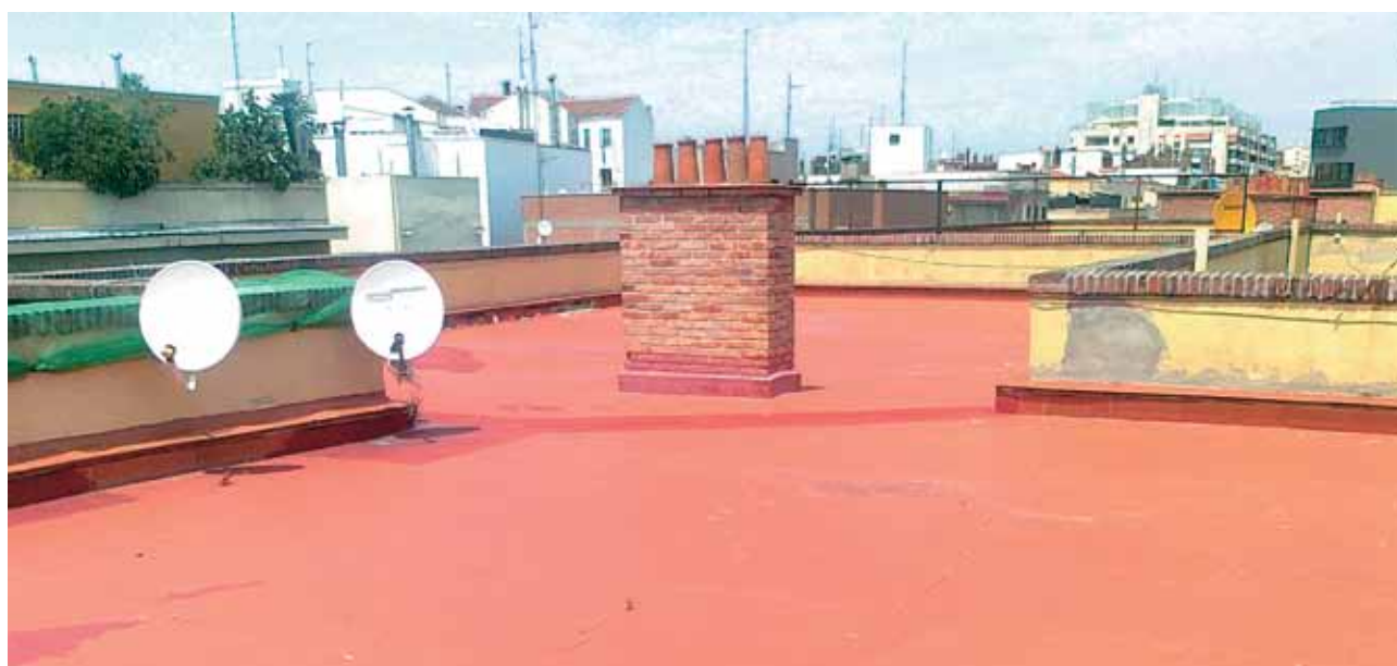
Toiture avec ancien traitement qui doit être éliminé
