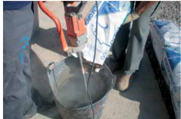
Mélange sur le chantier de MORCEM GROUT 500 Usine de dessalement à Almería
