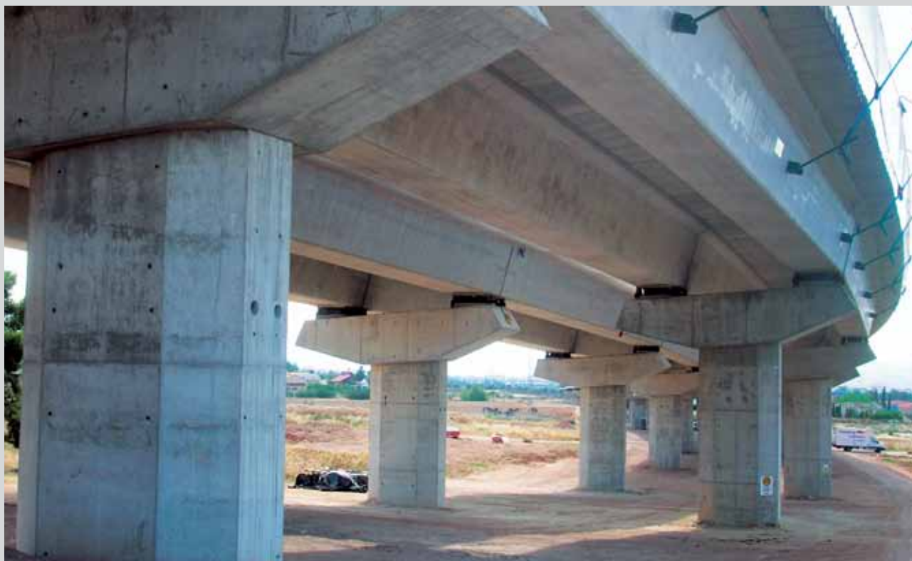
Détail d'un appui en néoprène sur un tronçon ferroviaire de l'AVE à Crevillent (Alicante)
