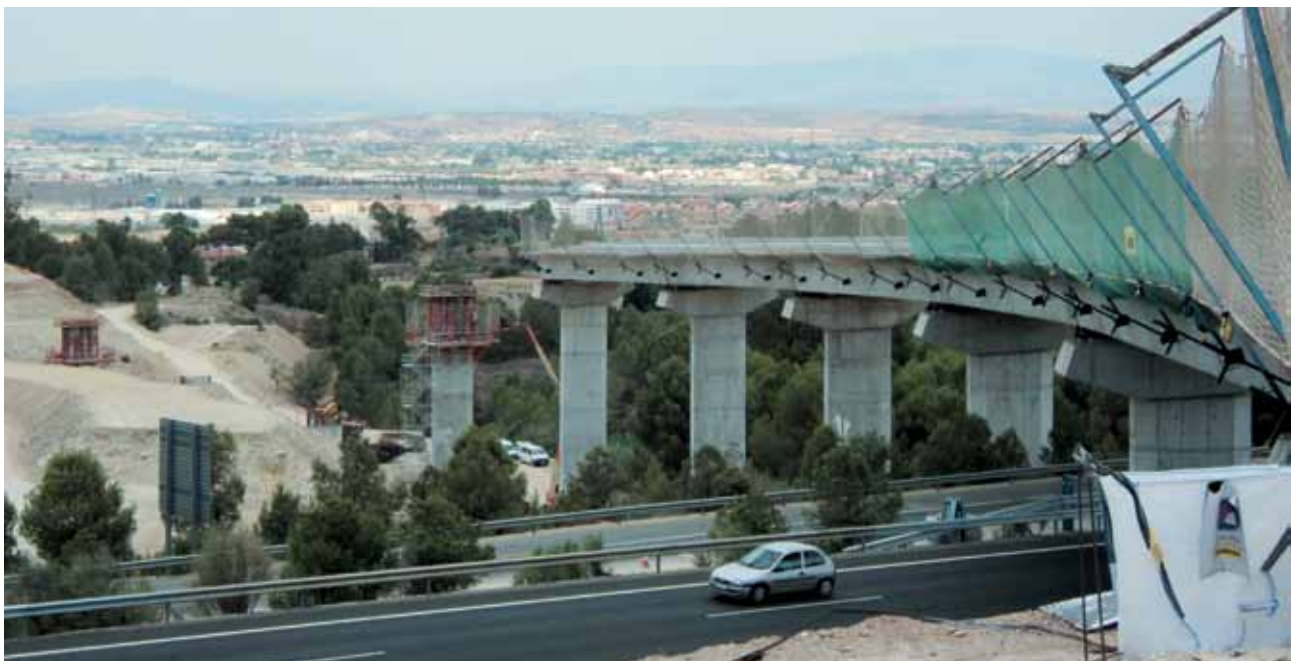
Vue générale du viaduc principal de la route MU-31 (Murcie)
