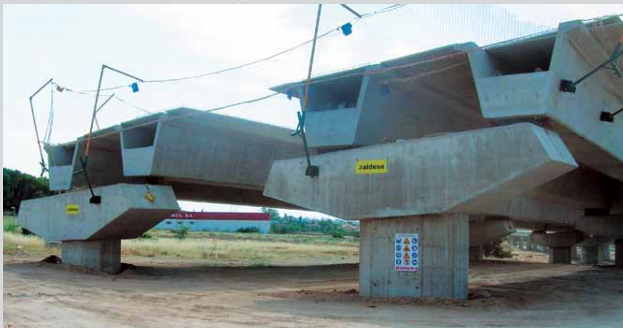
Détail d'appuis en néoprène nivelés avec MORCEM GROUT 500 sur la route MU-31 (Murcie)
