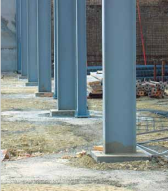
Détail de nivellement et de remplissage sous plaque à structure métallique
