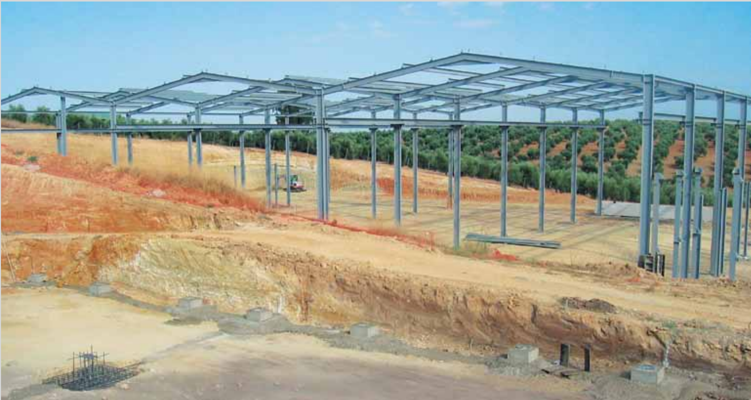
Bâtiments avec structure métallique à Arjonilla (Jaén)
