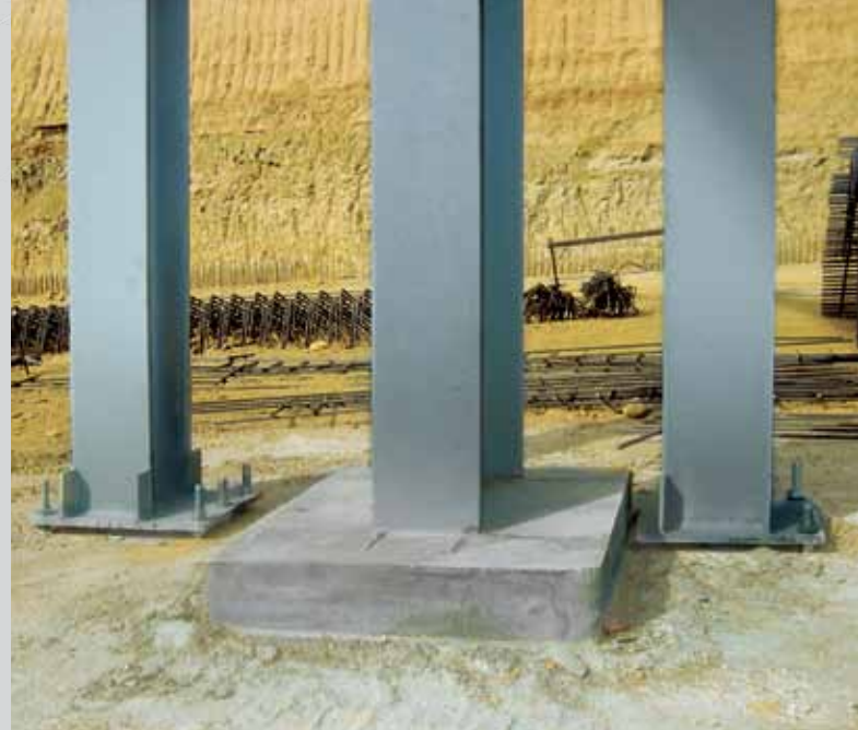
Détail de nivellement et de remplissage sous plaque à structure métallique
