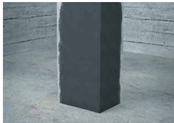
4- Reconstitution avec les mortiers nécessaires
