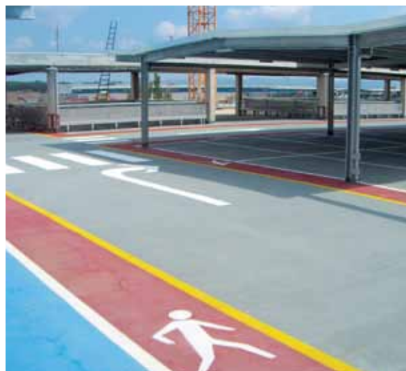
Finition de la toiture-parking avec des vernis de protection pour circulation intensive
