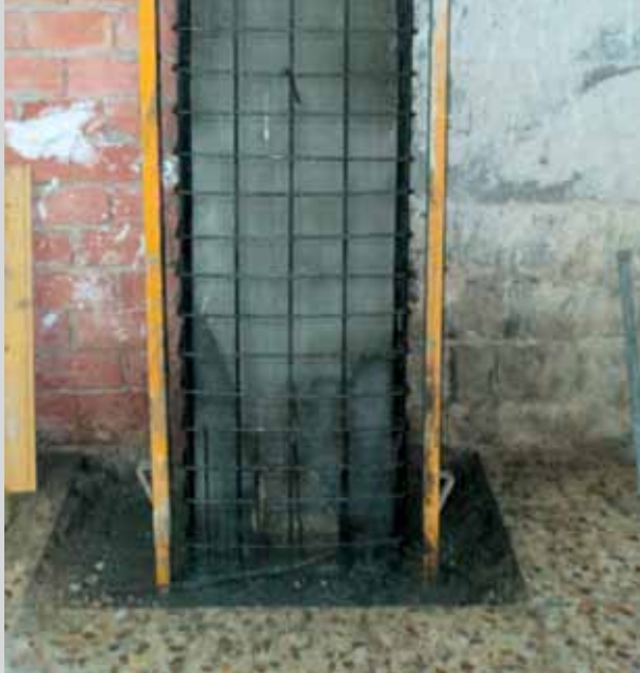
Renforcement et surélévation de pilier avant réception de MORCEMREST EF 50 à Elche (Alicante)
