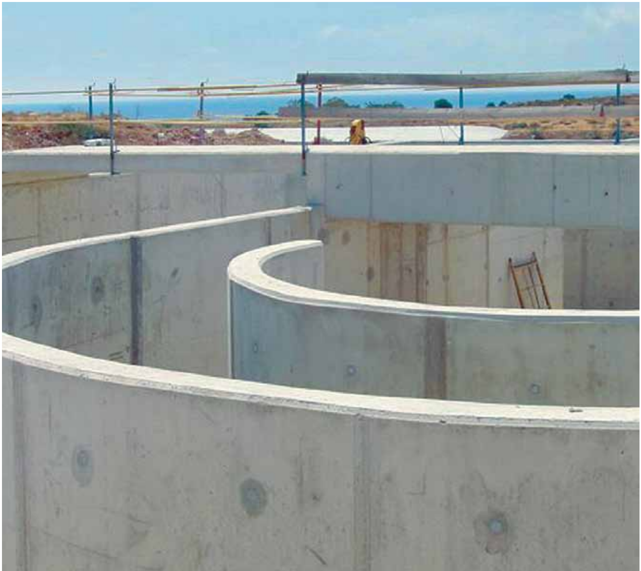
Imperméabilisation EDAR à Mazarrón (Murcie)
