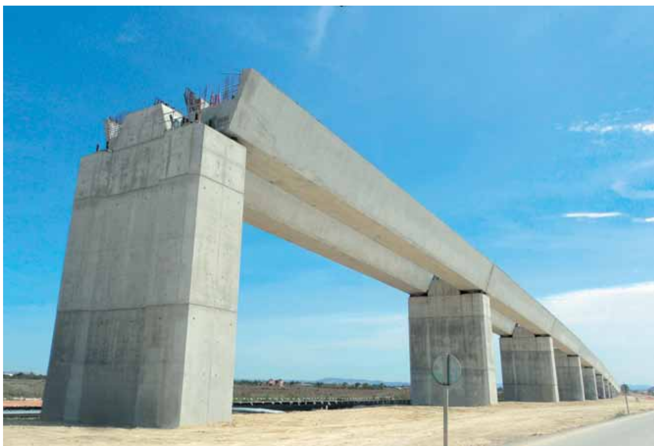
Nivellement d'appuis sur un tronçon ferroviaire de l'AVE à Crevillent (Alicante)
