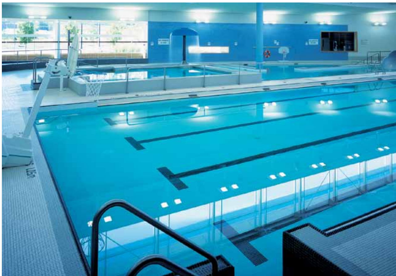
Imperméabilisation de piscine
