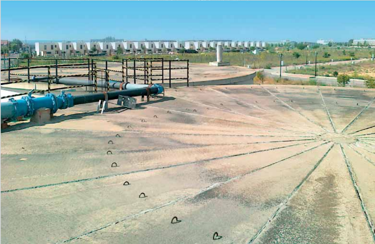
Imperméabilisation de toiture de réservoir par traitement des joints avec MEMBRANE ÉLASTIQUE H
