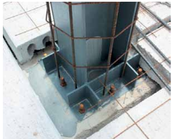
Application par déversement de MORCEM GROUT 500 dans le Parc Technologique de Martos (Jaén)
