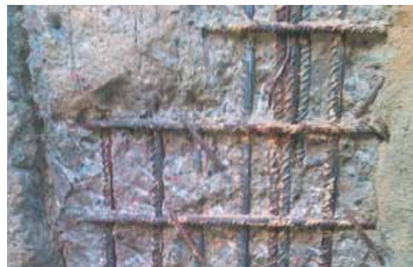
Armature corrodée
