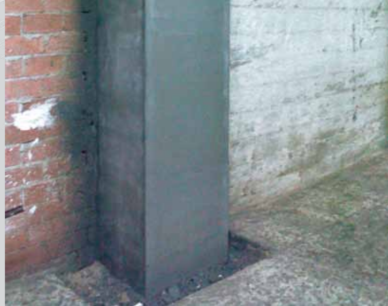
Surélévation de pilier après projection de MORCEMREST EF 50 à Elche (Alicante)
