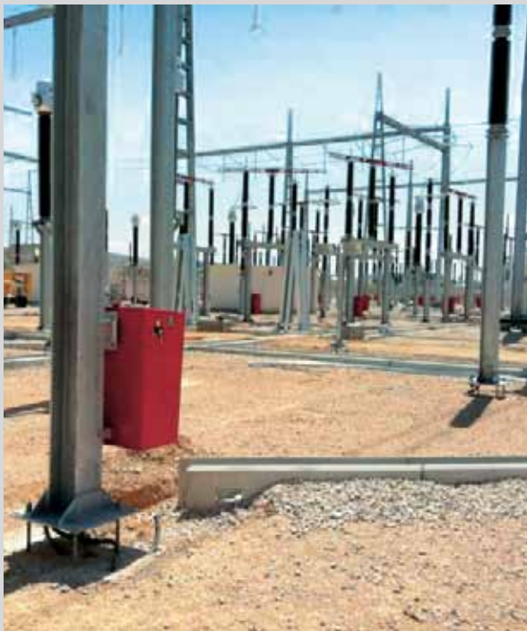
MORCEM GROUT 500 dans une sous-station électrique REE Mezquita de Jarque (Teruel)
