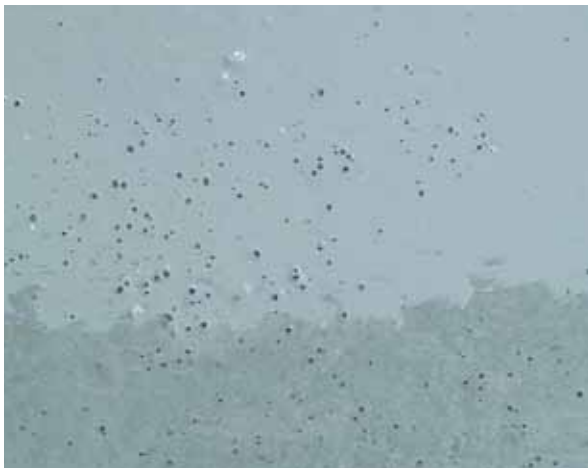
Scellement de pores défectueux dû à l'absence de primaire
