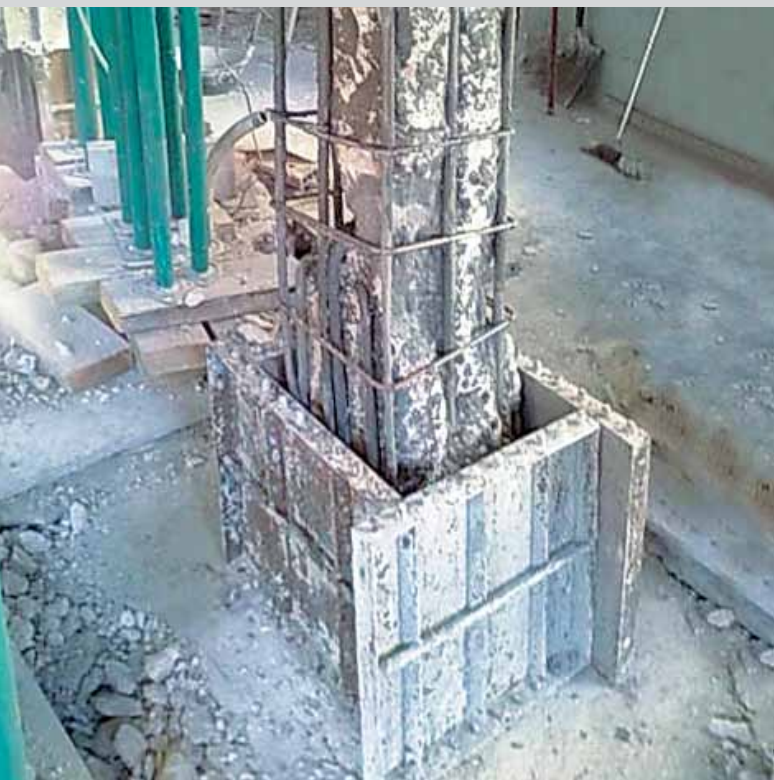
Préparation d'un coffrage pour l'application postérieure de MORCEMREST MH à Tavernes de Valldigna (Valence)
