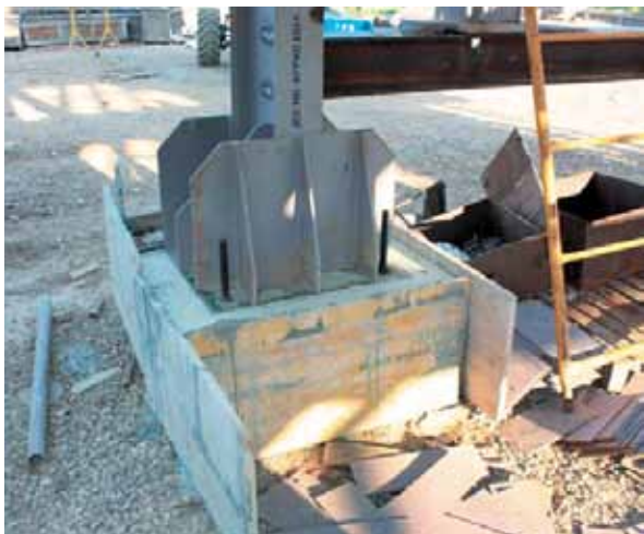
Installation des coffrages Usine de biodiesel à Andujar (Jaén)
