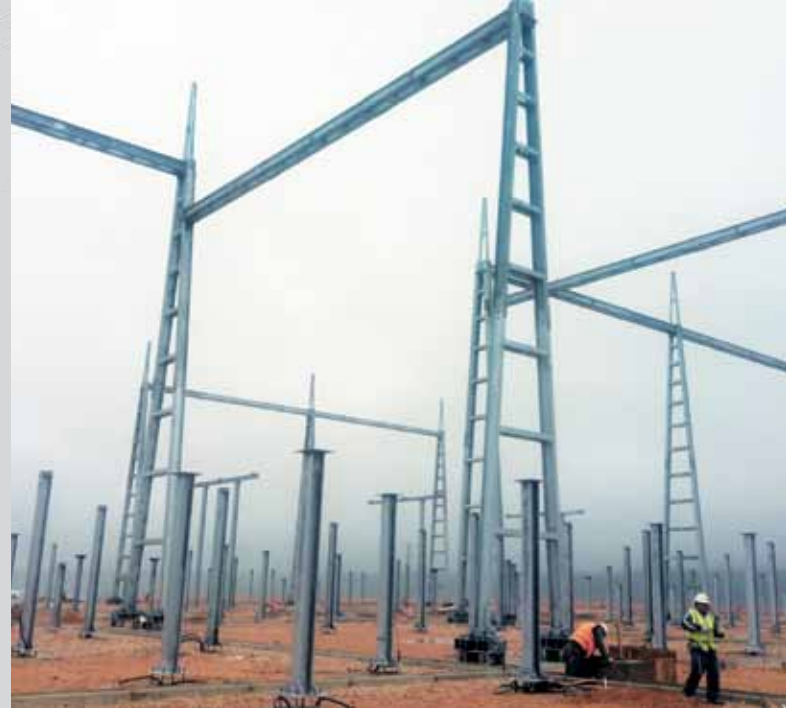
MORCEM GROUT 500 dans une sous-station électrique REE Mezquita de Jarque (Teruel)
