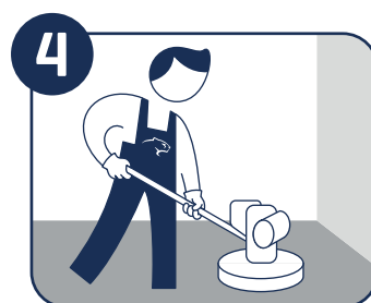
Fratasar hasta obtener una película monolítica superficial
