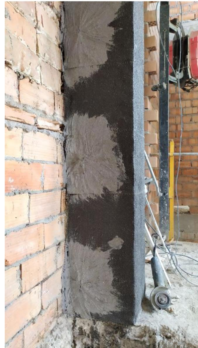
Conectores Carbotec – Anclaje de tejido en confinamiento de pilares a 3 y 2 caras (medianeras)
