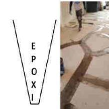
Fisuras entre 2 y 4 mm: con el fin de compensar los posibles movimientos de la fisura es conveniente utilizar adhesivo o mortero epoxi armado con malla de fibra de vidrio.
