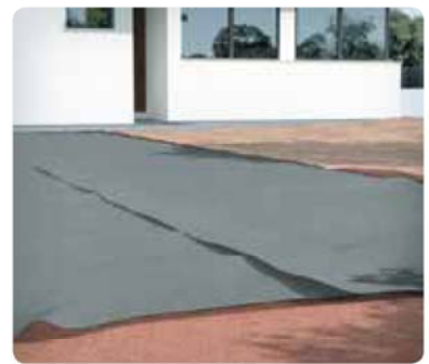
2 Colocar el geotextil PAVIGARDEN ANTIHIERBAS.
