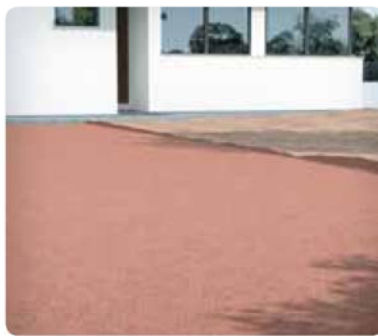
1 Limpiar, alisar y compactar el terreno.
