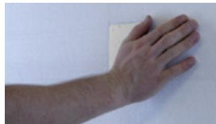
Presionar Traditerm ISO Power-Block 2G hasta enrasar dicha porción con la superficie del resto de fachada.
