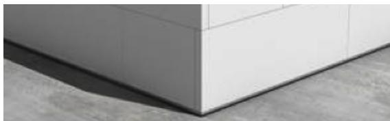
En ningún caso debe aplicarse mortero adhesivo entre placas en la formación de la esquina.
