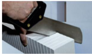
Con la ayuda de una sierra manual o un cortado de alambre caliente, cortaremos el espesor de Traditerm ISO Power-Block 2G a la medida necesaria.
