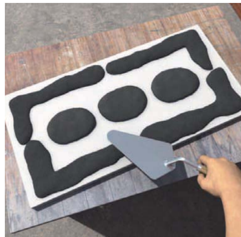
Método de Cordón de Mortero
