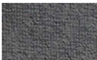
Detalle del estado de la superficie de la banda malla una vez colocada con mortero Traditem®
